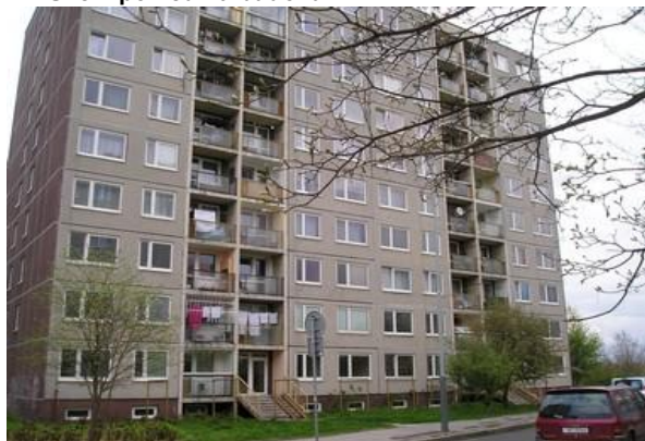
F1 Uliční pohled na budovu
